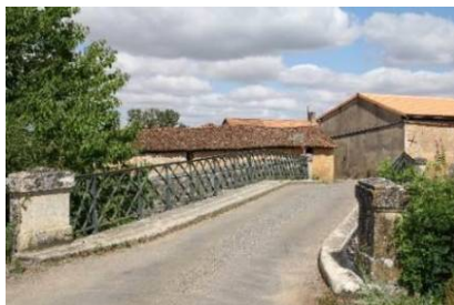
Pont de Larsac
